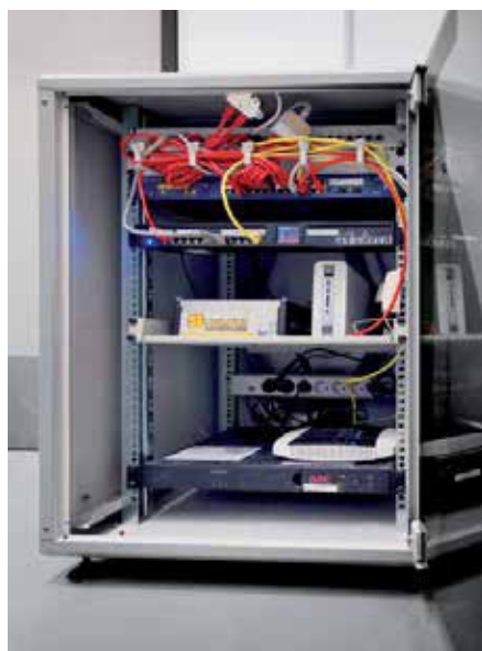
Das gebäudetechnische „Gehirn“ der Anlage: Im Gira FacilityServer laufen alle Informationen des KNX-Systems zusammen.
