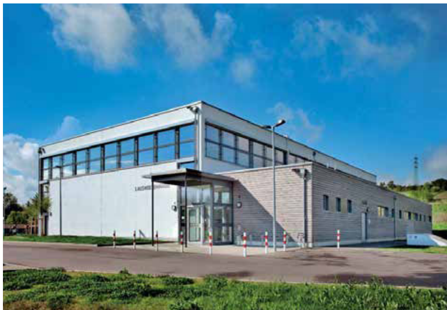
Die Lauswiesenhalle in Schorndorf-Haubersbronn ist ein Vorreiter, was Energieeffizienz, Wirtschaftlichkeit und Sicherheit betrifft – dank intelligenter Vernetzung aller haustechnischen Gewerke.
